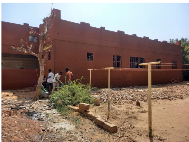
Das neue Auditorium im Centre Persis in Ouahigouya
